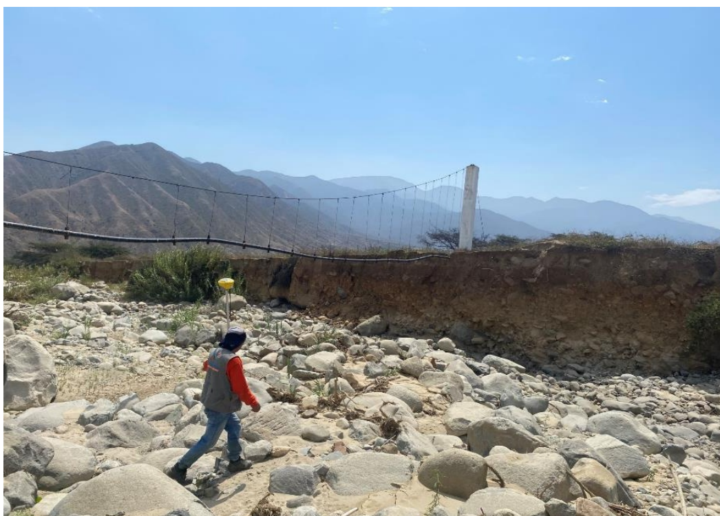
FIGURA N° 03: EN LA TEMPORADA DE MAXIMAS AVENIDAS, EL RÍO SINSICAP, SE DESBORDA EN ESTE TRAMO DEL SECTOR PUENTE COLLAMBAY, ARRASANDO CON TODO LO QUE ENCUENTRA A SU PASO, ACA SE VE LA EROSION DE LA VIA ADYACENTE.
